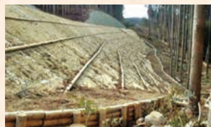
杉円柱加工丸太使用 木製筋工
